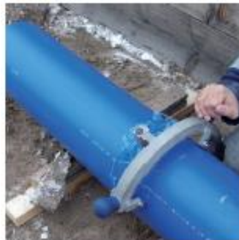
Usuwanie warstwy utlenionej w miejscu Mocowania siodła
