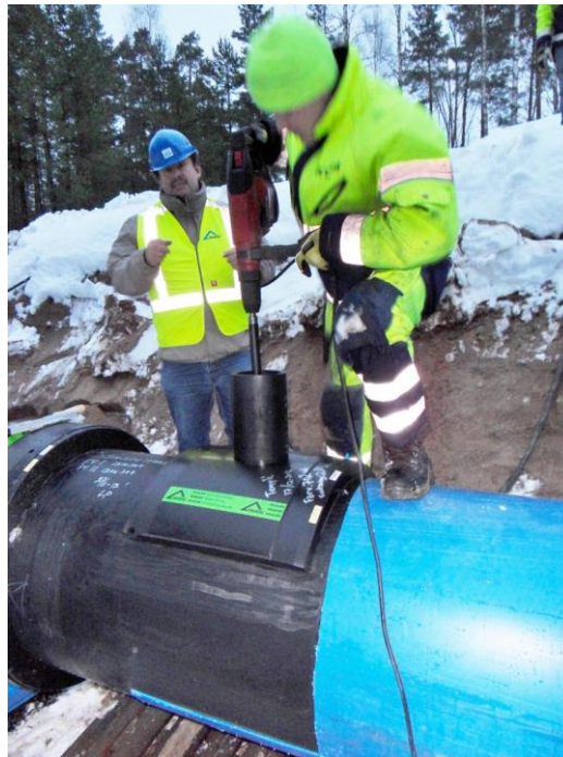
Mufy d740mm, Obejmy siodłowe SA XLd740/160mm
