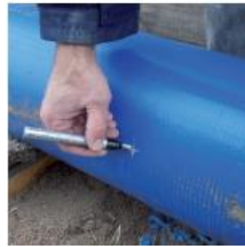
Zaznaczenie miejsca nawiercania
