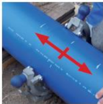
Oznaczenie strefy zgrzewania siodła naprawczego
