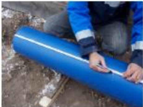
Oznaczenie punktu wypływu wody
