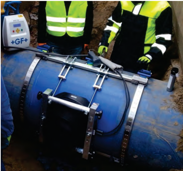
Rys. 7. Skrobaki do przygotowania powierzchni pod montaż obejmy
