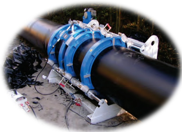
Rys. 4. Zgrzewanie doczołowe
