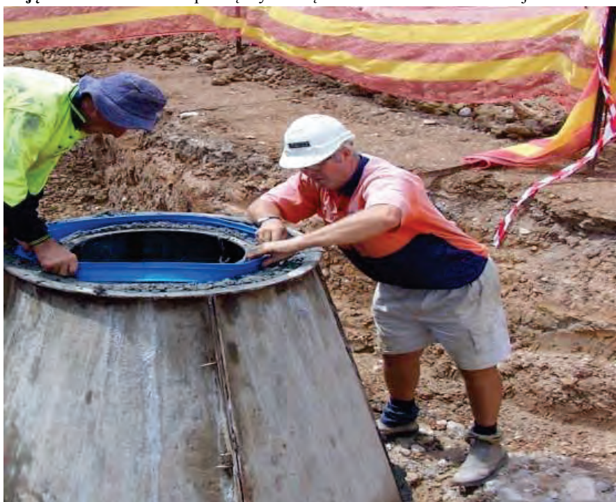
Zdjęcie 5. Uszczelnienie pomiędzy trzonem a zwieńczeniem studni betonowej
