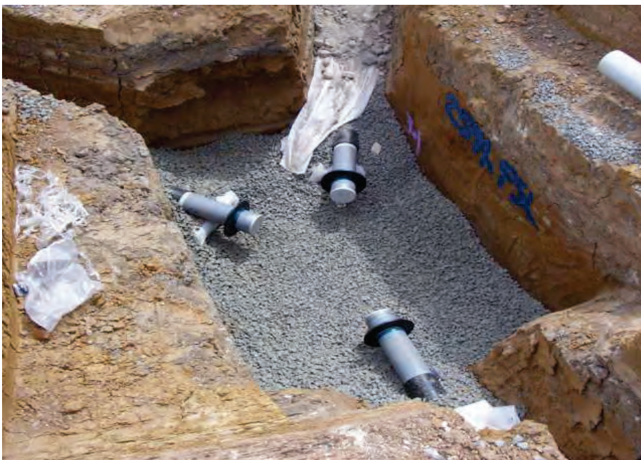
Zdjęcie 2. Przed wylaniem betonowej kinety. Kolnierze uszczelniające na rurach
