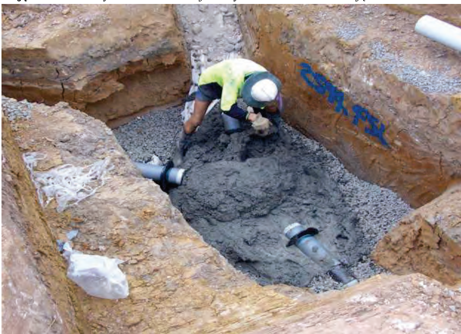
Zdjęcie 3. Wylanie betonowej kinety
