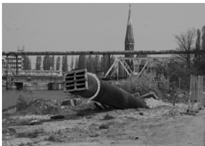
Fot. Rurociąg po zakończonej instalacji
