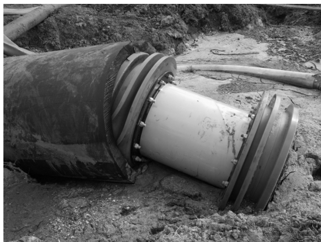
Fot. Tłokowanie rurociągu HDPE 1000 mm
