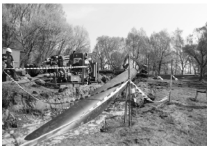
Fot. Instalacja rurociągu HDPE 1000 mm
