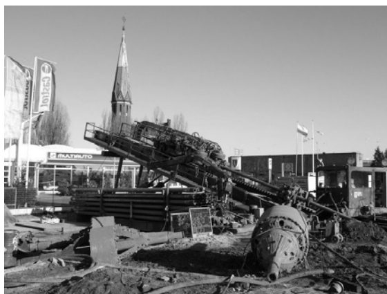
Fot. Urządzenie wiertnicze klasy 2500 kN
