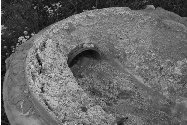
Zdjęcie nr 1 i 2. Korozja chemiczna studzienki betonowej
