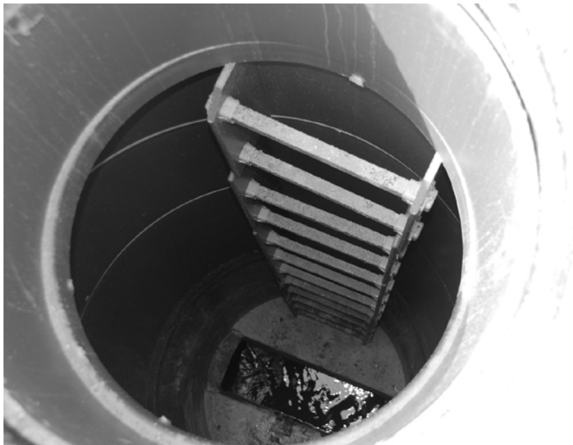
Zdjęcie nr 3. Po wymianie na studzienki z tworzywa sztucznego
