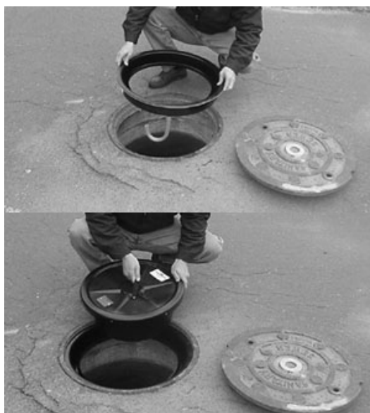
Zdjęcie nr 6 i 7. Montaż filtra antyodorowego.
