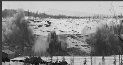
Początek prac z materiałami wybuchowymi, kwiecień 2008
