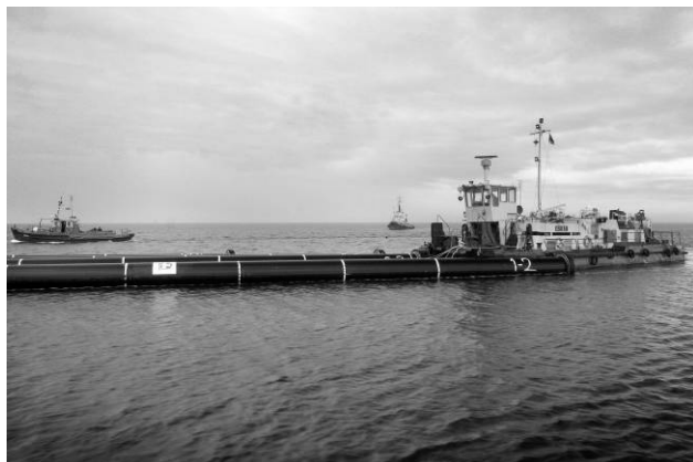
Fot. 3 Holowanie rur PE drogą morską oraz Wisłą
