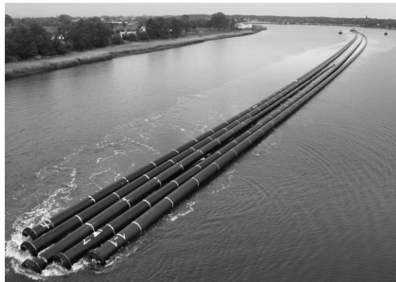
Fot. 3 Holowanie rur PE drogą morską oraz Wisłą
