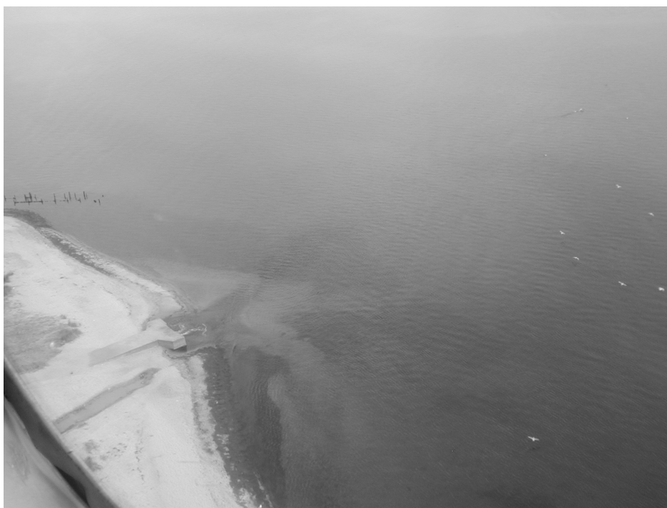
Fot. 2. Rejon ujścia kolektora brzegowego w Mechelinkach.
