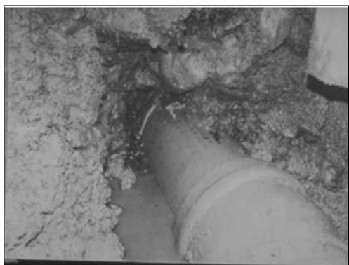
Rys. 2: Przeciekająca rura
