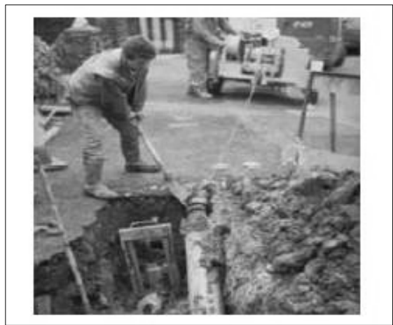
Rys. 9 Horyzontalny przewiert sterowany
