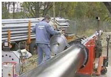
Rysunek 1. Zgrzewanie elektrooporowe (po lewej) i zgrzewanie doczołowego (po prawej).
