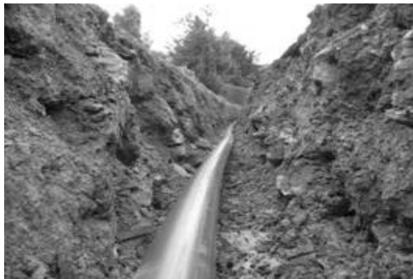
Rysunek 7. Wodociąg układany bez podsypki z piasku
