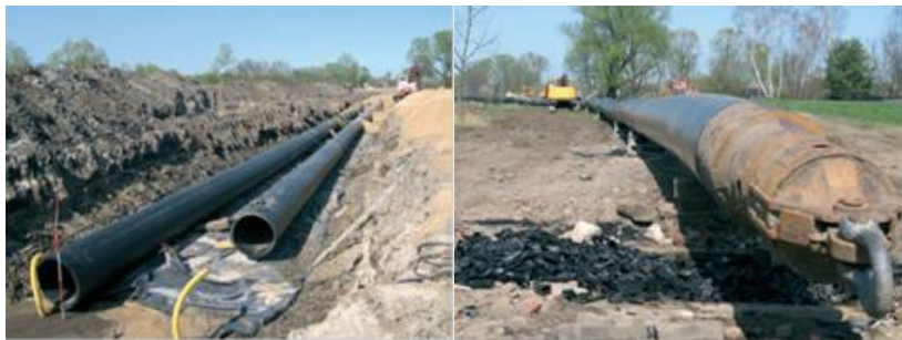
Rys. 28. Rurociągi tłoczne do oczyszczalni Pomorzany – układanie rur w wykopie otwartym
