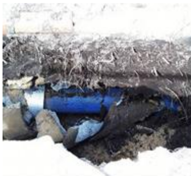
Rys. 22. Przykłady zastosowania rur PE z warstwami ochronnymi w pipe bursting
