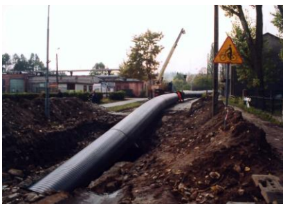
Rys. 19. Przykłady zastosowania technologii bezwykopowej do renowacji długimi odcinkami:
