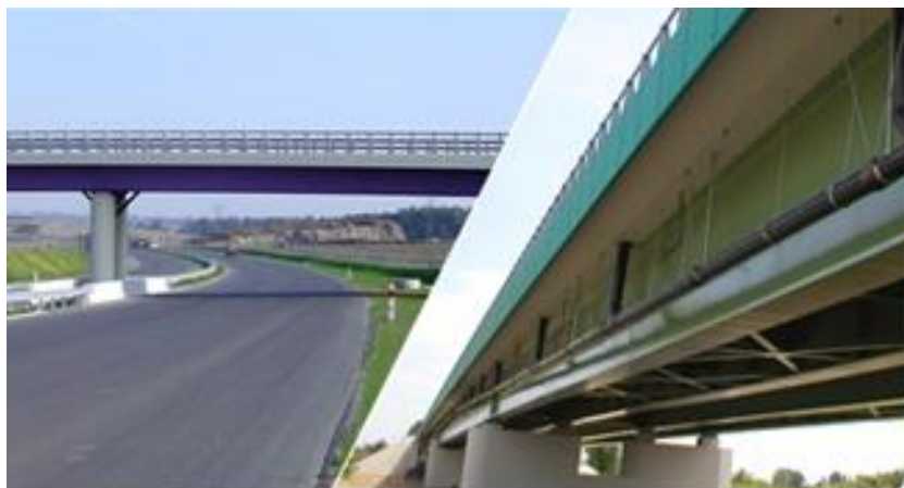
Rys. 14. Przykład odwodnienia obiektów mostowych za pomocą systemu z PE
