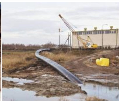
Rys. 21. Przykłady zastosowania rur z tworzyw sztucznych w technologii HDD – przewiert horyzontalny:
