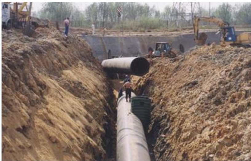
Rys. 8. Przykład kolektora kanalizacyjnego wykonanego systemowo z rur i studni z polietylenu. Średnica kolektora 1500 mm
