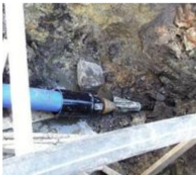
Rys. 22. Przykłady zastosowania rur PE z warstwami ochronnymi w pipe bursting
