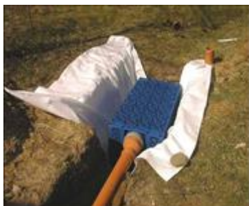
Rys. 15. Przykłady zastosowania skrzynek rozsączających:
