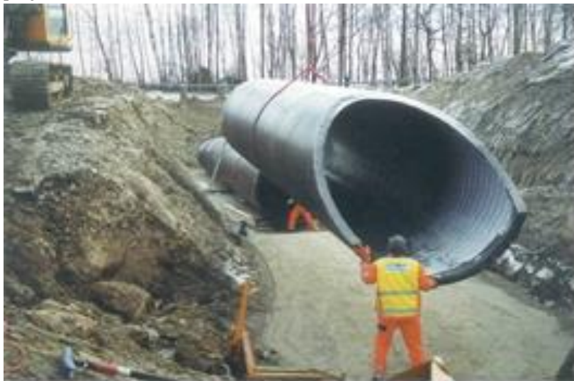
Rys. 24. Montaż przepustu drogowego z rury strukturalnej
