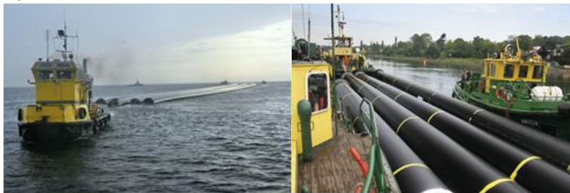
Rys. 27. Transport długich odcinków rur z PE drogą morską
