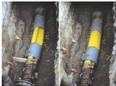
Rys. 23. Przykłady zastosowania rur PE w technologii ciasnopasowanej
