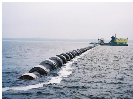
Rys. 25. Przykłady zastosowania swobodnego zatapiania rur PE w rzece i otwartym morzu:
